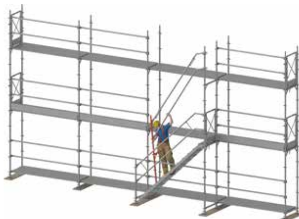
Figure 44 : Montage des mains courantes d'escalier sur cadre en T.
