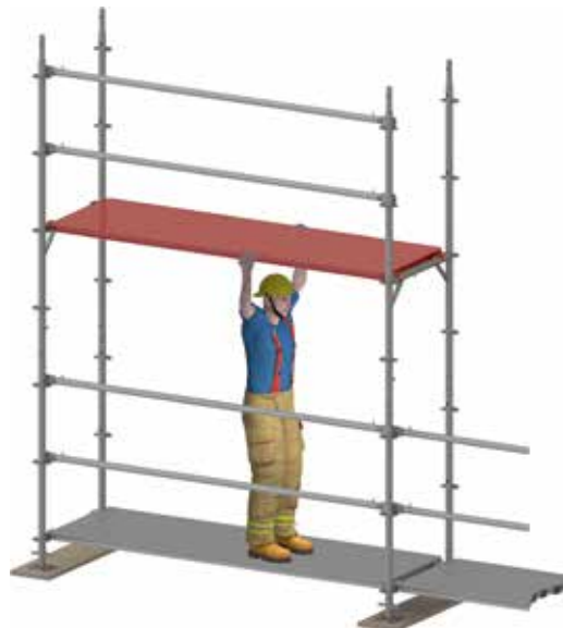
Figure 19 : Montage plateau.
