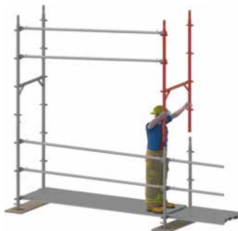
Figure 17 : Soulèvement cadre en H.
