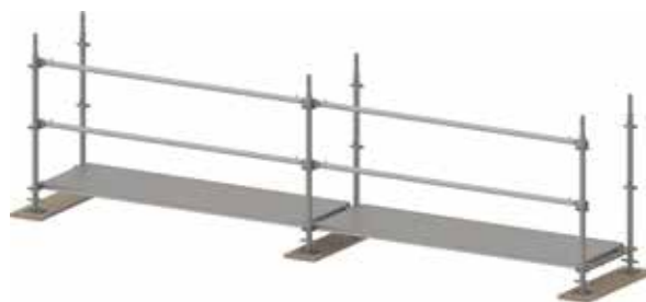
Figure 11 : Premiers champs d'échafaudage montés et alignés.
