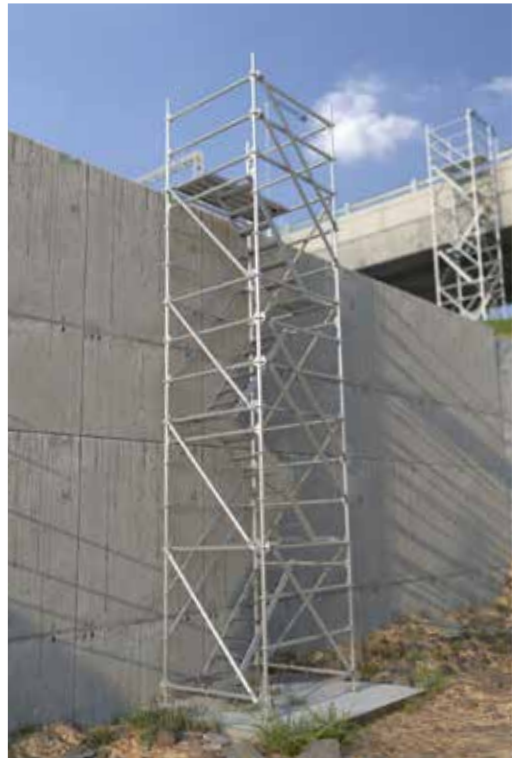
Accès au chantier tour d'escalier
